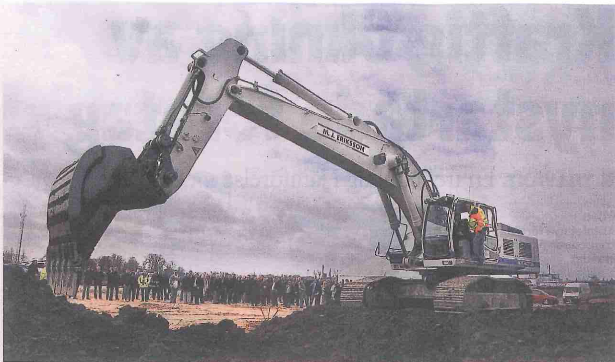
I går togs ett symboliskt spadtag för att markera byggstarten av DSVs nya logistikcenter inklusive huvudkontor.
